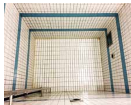
Das Becken wird im ausgelassenen Zustand auch von der MRAS-Gruppe für Bergübungen verwendet.
