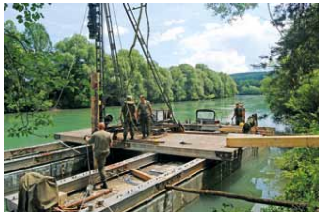
Über die Rammfahre der Villacher Pioniere wurden die Piloten in den Untergrund gerammt.
