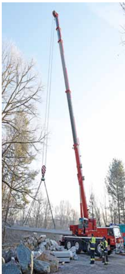
Mit dem Kran des KLFV wurden die tonnenschweren Betonplatten auf die Piloten gehoben.
