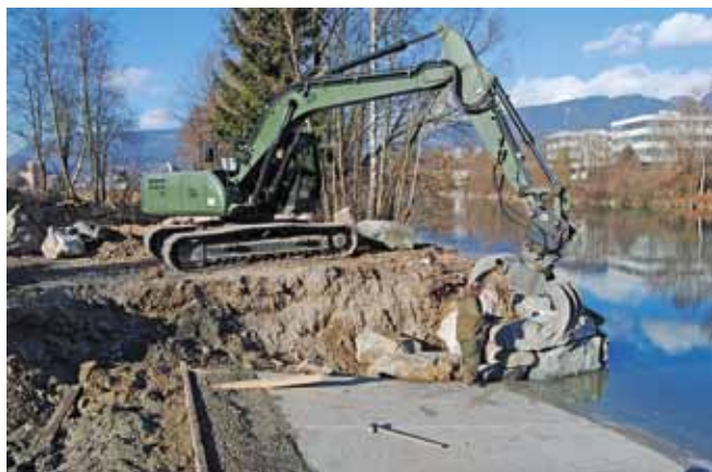
Die umfassenden Steinschichtungen erforderten Fingerspitzengefühl und Erfahrung des Baggerführers.
