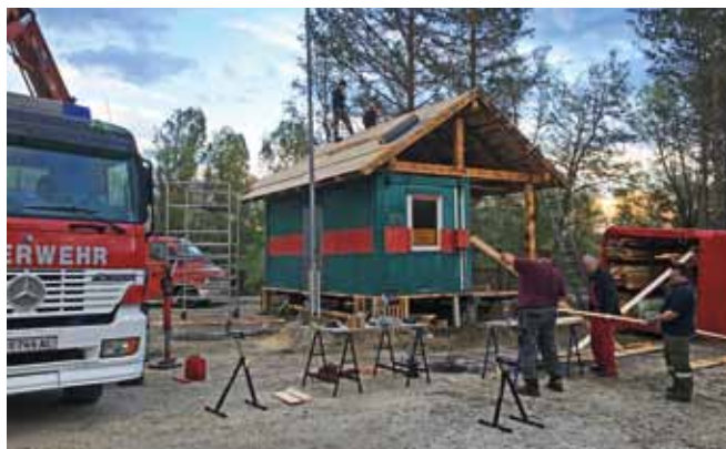
Im vorhandenen Bürocontainer wurde die Elektroinstallation nachgerüstet, ein Dachstuhl aufgesetzt sowie die Fassade zimmermannsmäßig verkleidet.
